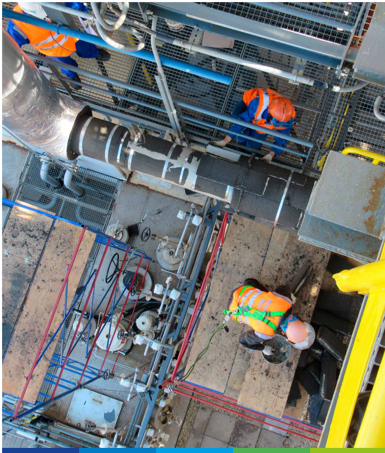
Isolierungsarbeiten
